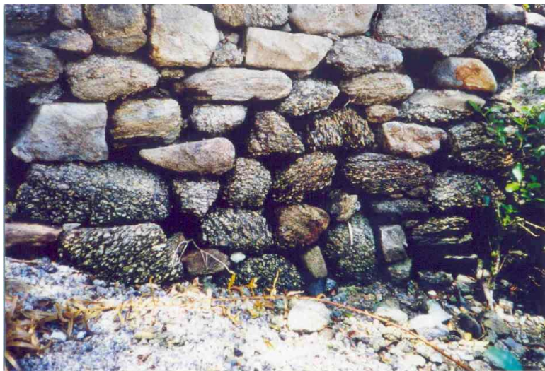
Fig. 4 – Detalhe da murada, diante do mar, que mostra a alvenaria em perfeito estado. (P.Naus 04 – SW1986)
