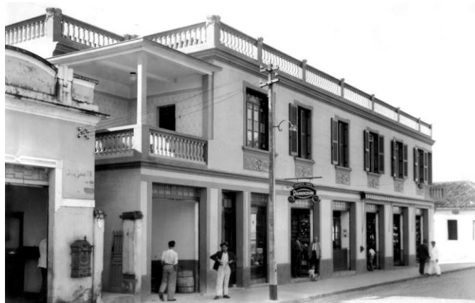
Residência e comércio de Frederico Blasi em São João da Boa Vista
