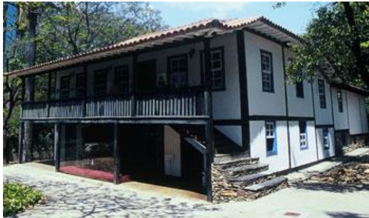
Museu Histórico Abílio Barreto, no Bairro Cidade Jardim em Belo Horizonte, instalado na casa sede da Fazenda do Leitão, restaurada pelo Patrimônio Histórico e Artístico Nacional.
