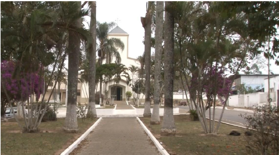
Aranha, distrito de Brumadinho/MG, local onde Agenor Monteiro da Silva foi batizado.
