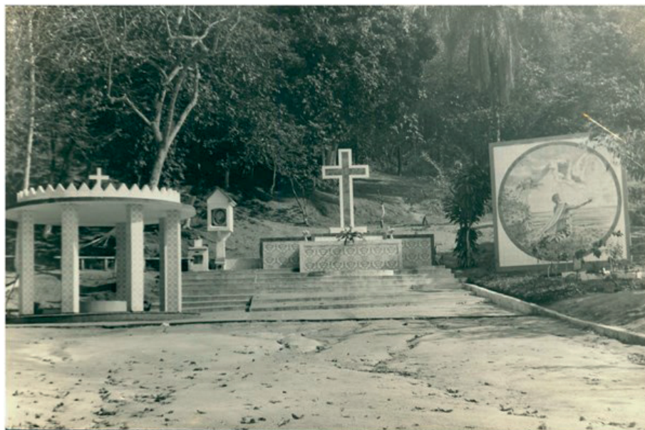
Sítio histórico do Poço Bento de Anchieta (IBGE, 1969)
